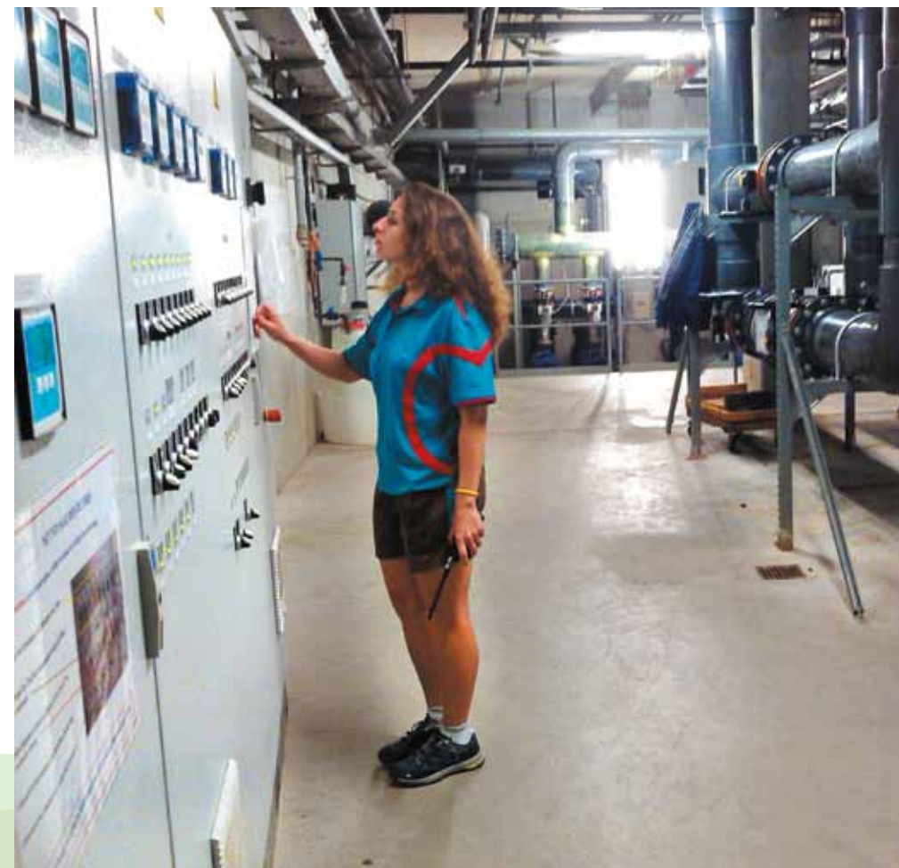
Contrôle technique des installations de l'Aquamundo
